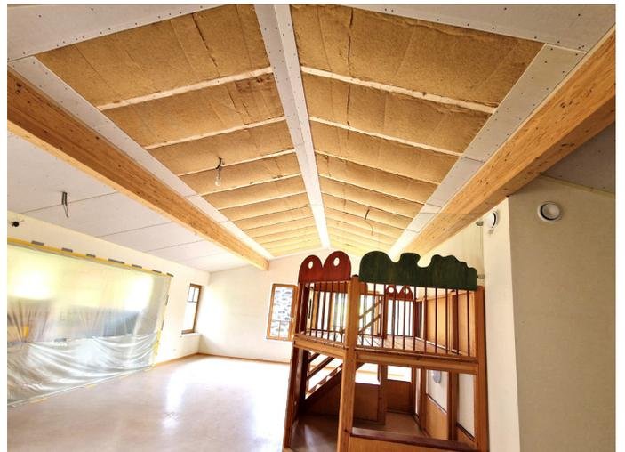
In den Ferien wurden in den Gruppenräumen und im Bewegungsraum Deckenelemente für Schallschutz und Wärmedämmung eingebaut.
