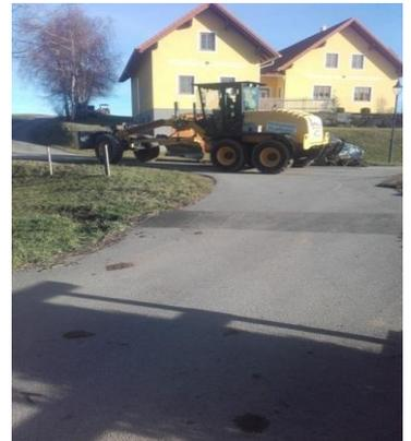
Im Programm der „Ländlichen Entwicklung“ konnten die Erdbaumaßnahmen am Verbindungsweg Hirschenhof-Thaurer abgeschlossen werden. Sobald es die Witterung im kommenden Frühjahr zulässt, soll hier noch die Feinplanie und anschließend die Asphaltdecke aufgetragen werden. Alle Rechnungen und Unterlagen liegen derzeit bei der Güterwegabteilung, wo eine Teilabrechnung durchgeführt wird.
