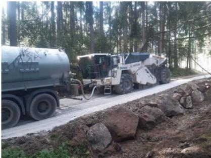
In Großschönau konnte ein Verbindungsweg wieder hergestellt werden. Der Verbindungsweg Gr. Otten – Schroffen war bereits zu sanieren. In Thaures musste der durch enorme Wurzelaufrühe beschädigte Weg Richtung Rothfarn auf eine Länge von 200 m generalsaniert werden.
