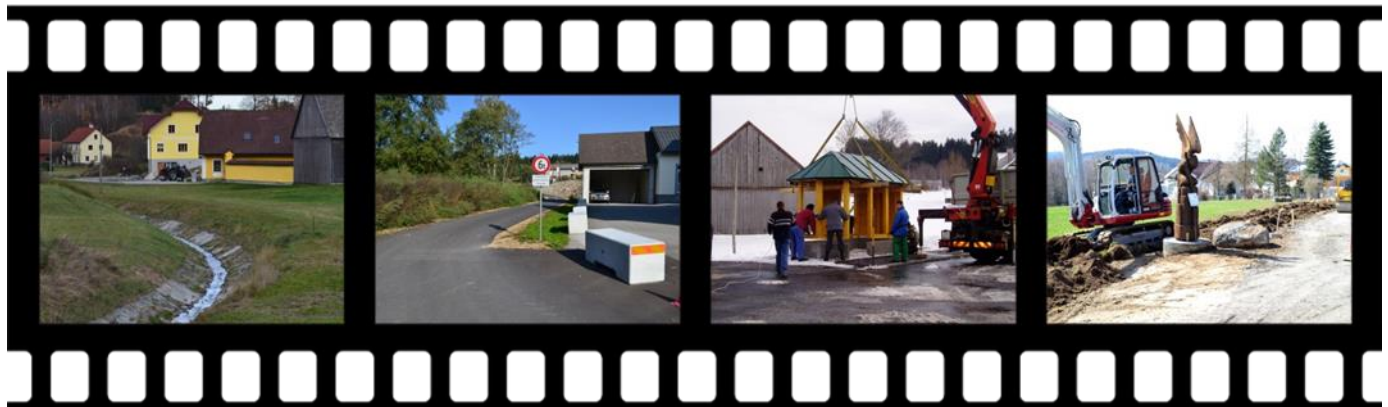
Bachsanieierung in Engelstein
