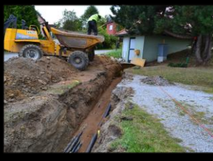
Neue Wasserzuleitungen WVA Großschönau
