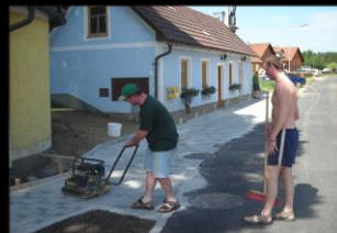
Ortsstraße nach Kanalbau in Thaures
