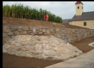
Stützmauer bei Kapelle in Großotten
