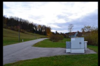
Abwasser- und LWL Datenleitung in Wachtberg
