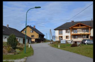
Landesstraßenbau mit Nebenflächen in Zweres
