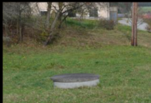
Löschwasserbehälter in Zweres
