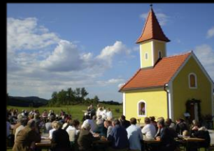
Kapellensanierung in Mistelbach
